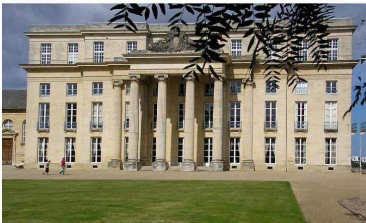
Château de Bénouville, south front.
